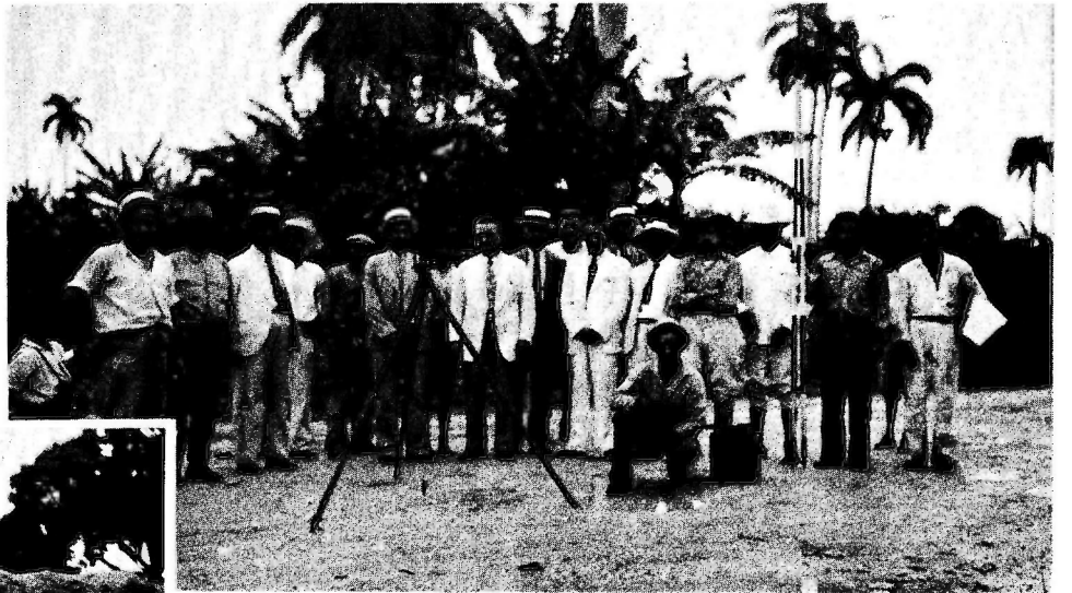
LA CARRETERA DE CAIBARIEN A MAYAJIGUA.—El personal de la Secretaría de Obras Públicas dando comienzo a los trabajos de explanación de la carretera que ha de unir el puerto de Caibarién con la ciudad de Mayajigua, atravesando una riquísima zona.
